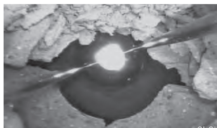
Figure 13 – Forage transversal typique dans conduite d'évacuation
