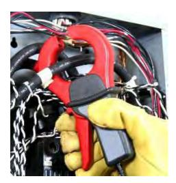
**Photo 2**: Install CT Around Conductor.
